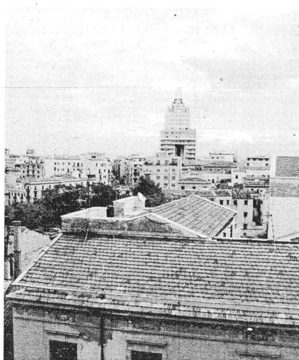
Restituzione dell'Imu: erogati anche 120 milioni per gli edifici comunali
